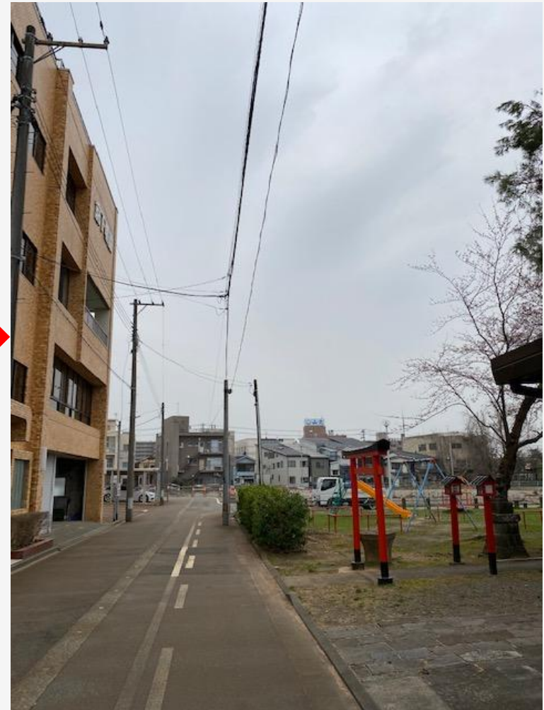
工事後の状態
