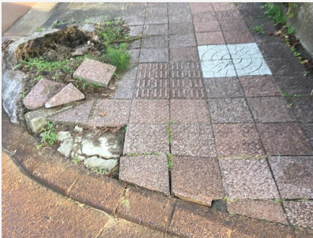
工事前の状態
