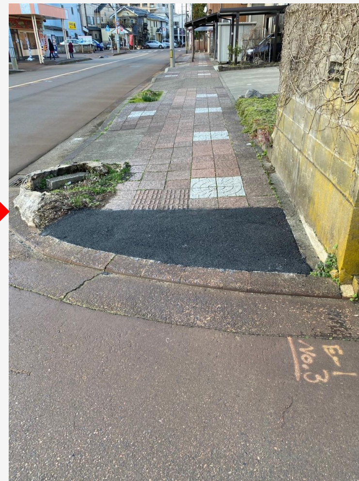
工事後の状態
