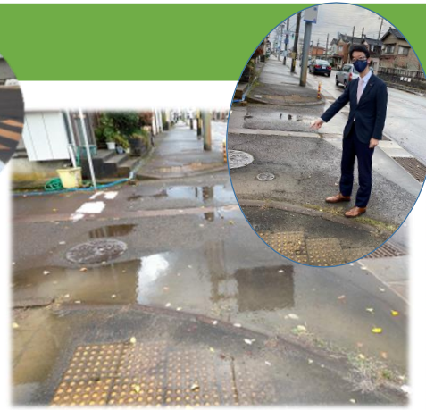
歩道付近の水溜まり状況確認（与板）
