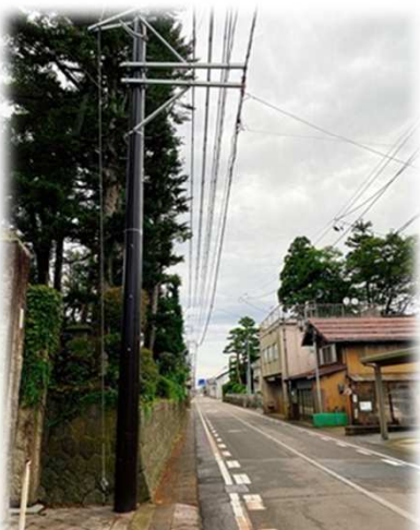
旧機那サフラン酒本舗前 市道にあった電柱移設工事が完了(撰田屋)
